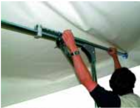
Ausrichten des Daches
