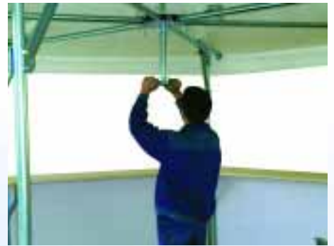
Spannen des Daches
